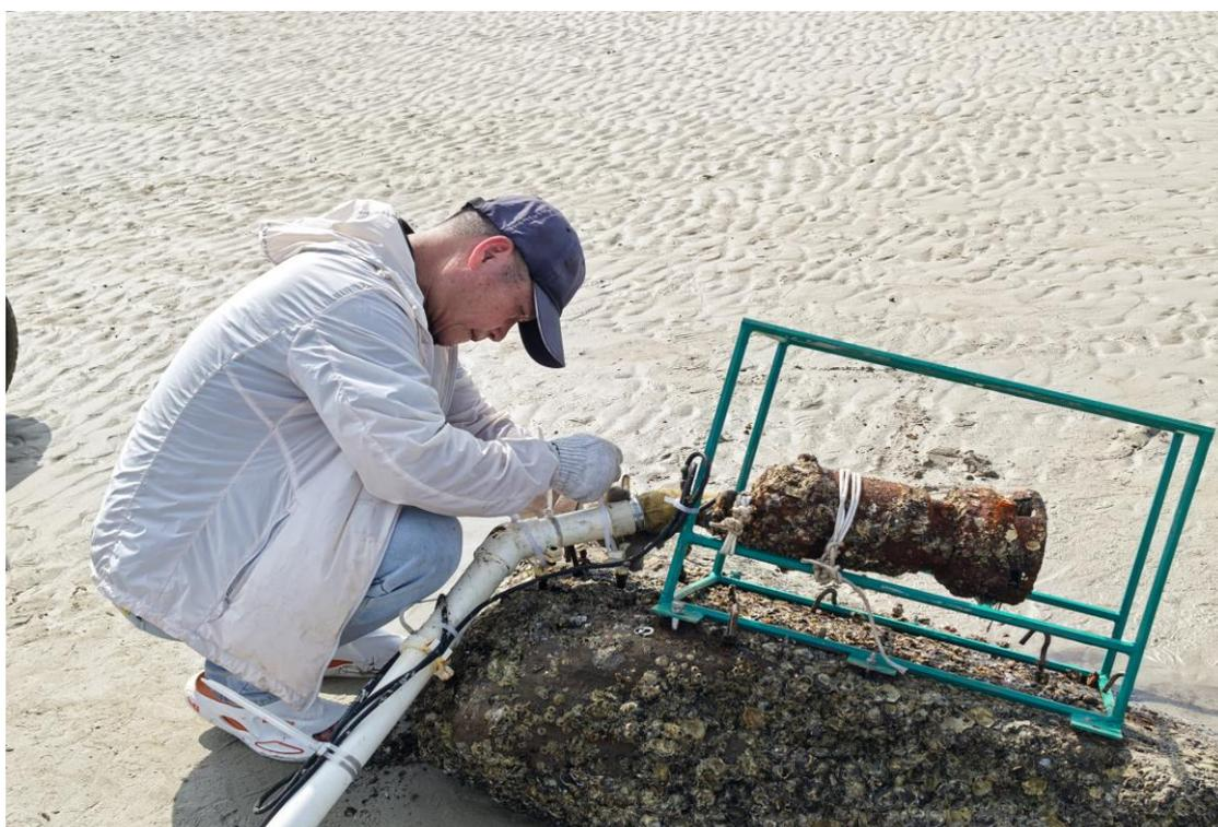
工作人员在更换加固海底抽水泵架子
