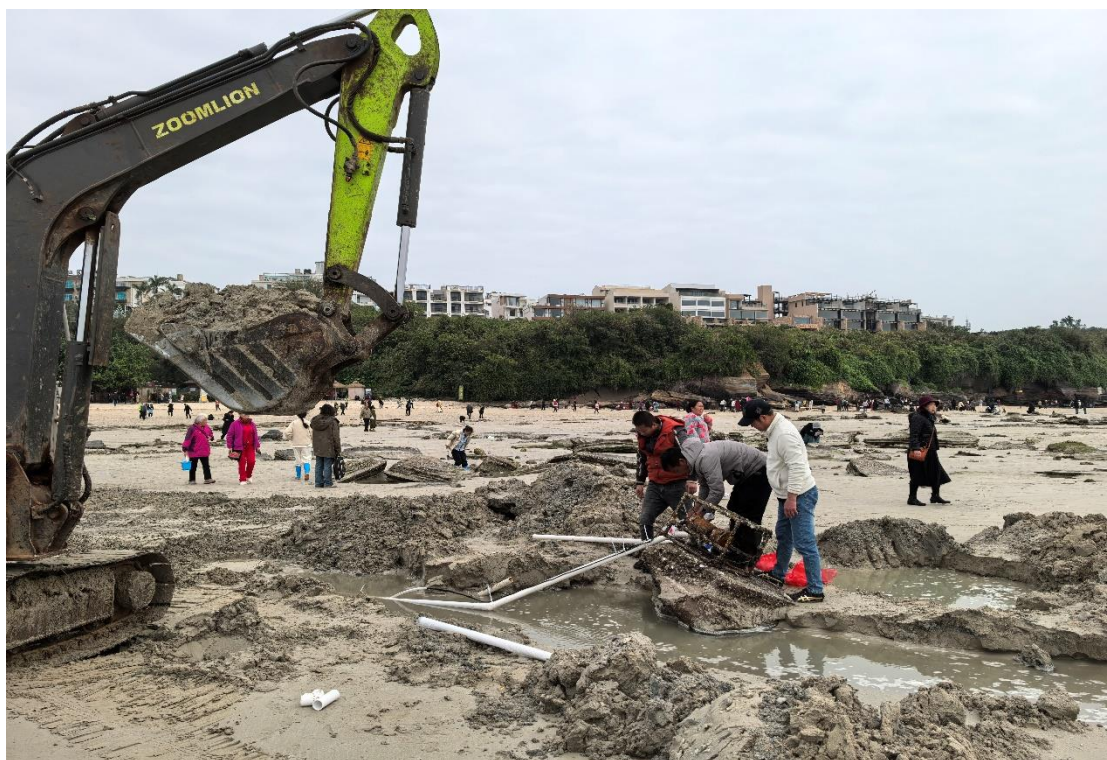
工作人员和工人在对海底管道进行固定和填埋
