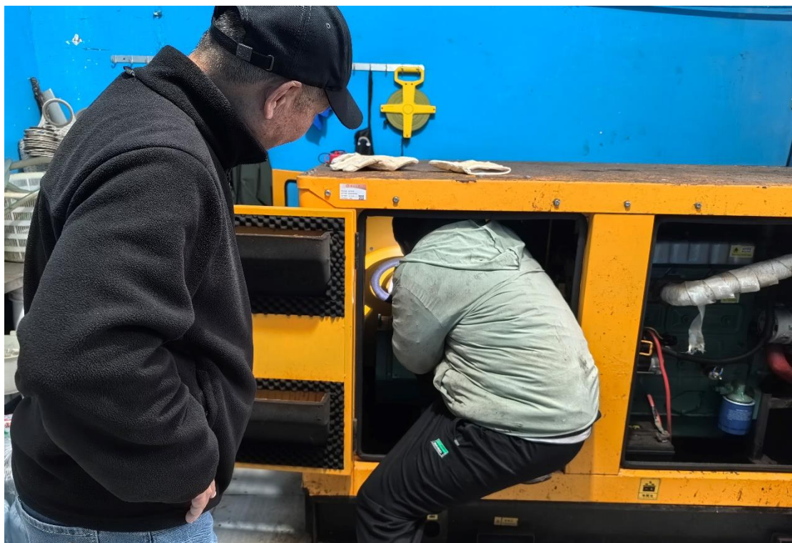
工作人员对发电机进行检修
