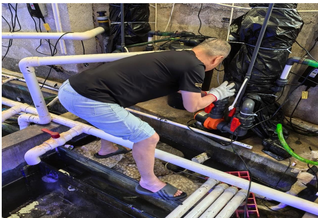
工作人员在检修蛋分的漏水情况并进行清洗工作
