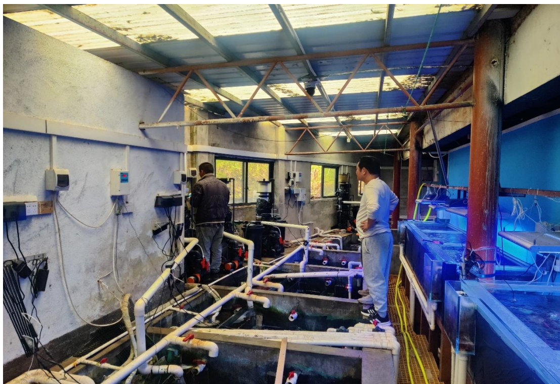
工作人员和电工在排查线路短路情况并进行维修
